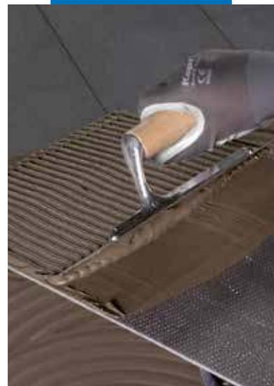
Нанесение клея на тыльную сторону плит
