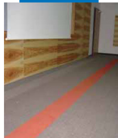
Пример использования Primer G перед нанесением Ultrplan Eco и клея Rollcoll для укладки коврового покрытия в номере отеля - Villa Hotel Castellani - Австрия
