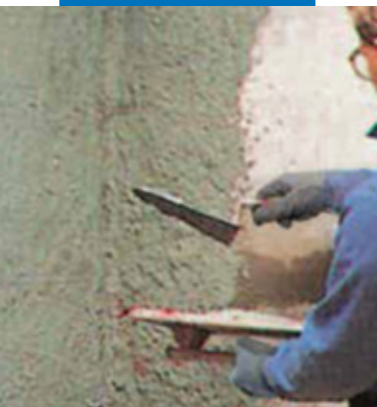
Нанесение адгезионной штукатурки с добавлением ADMIX P
