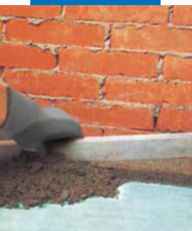
Укладка цементной стяжки с добавлением ADMIX P
