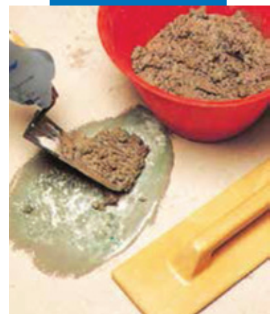
Ремонт пола: нанесение строительного раствора
