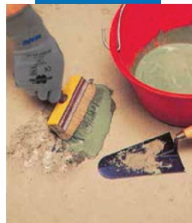
Ремонт пола с нанесением цементного раствора
