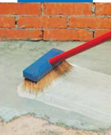
Нанесение цементного раствора с добавлением ADMIX P
