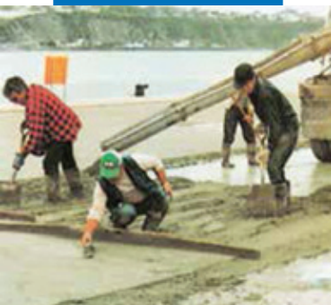
Цементная стяжка с добавлением ADMIX P – Вье Порт, Квебек, Канада
