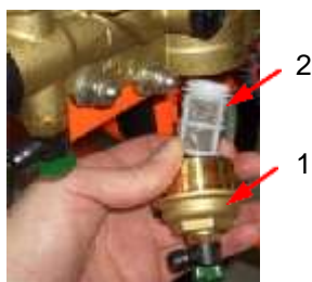
Рис. 81: Грязеулавливающая сетка
