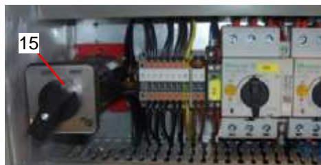
Рис. 14: Переключатель 230 В – 400 В
